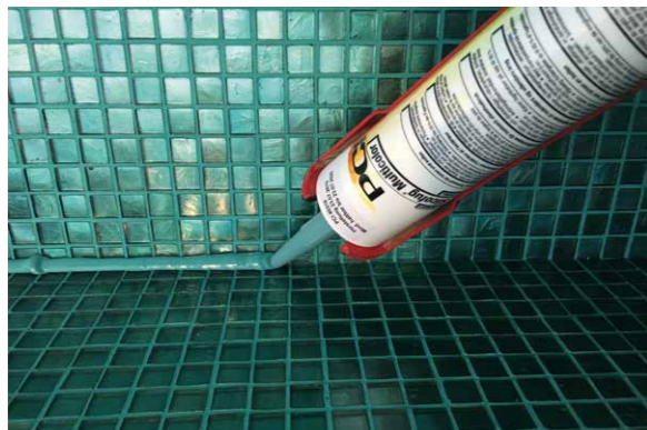
Leichtes Schließen von Eck-, Bewegungs- und Anschlussfugen im Sanitärbereich, in Schwimmbädern sowie auf Balkonen und Terrassen.
