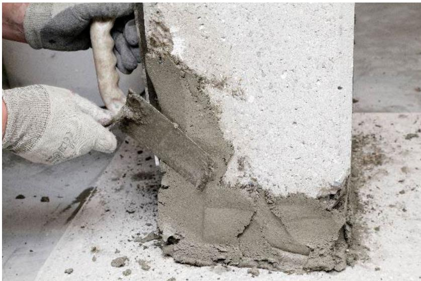
PCI-System für Betonreparatur mit statischem Anspruch (z.B. Säulen, Balkone und Treppen)
