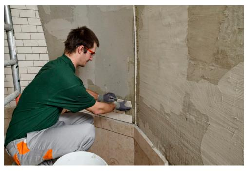
Der variable Flexmörtel PCI Nanolight kam bei der Verlegung der Fliesenriemchen in der Kuppel des römisch-irischen Dampfraumes zur Anwendung. Verfugt wurde mit dem zementären Fugenmörtel PCI Rapidfug. http://www.pci-
