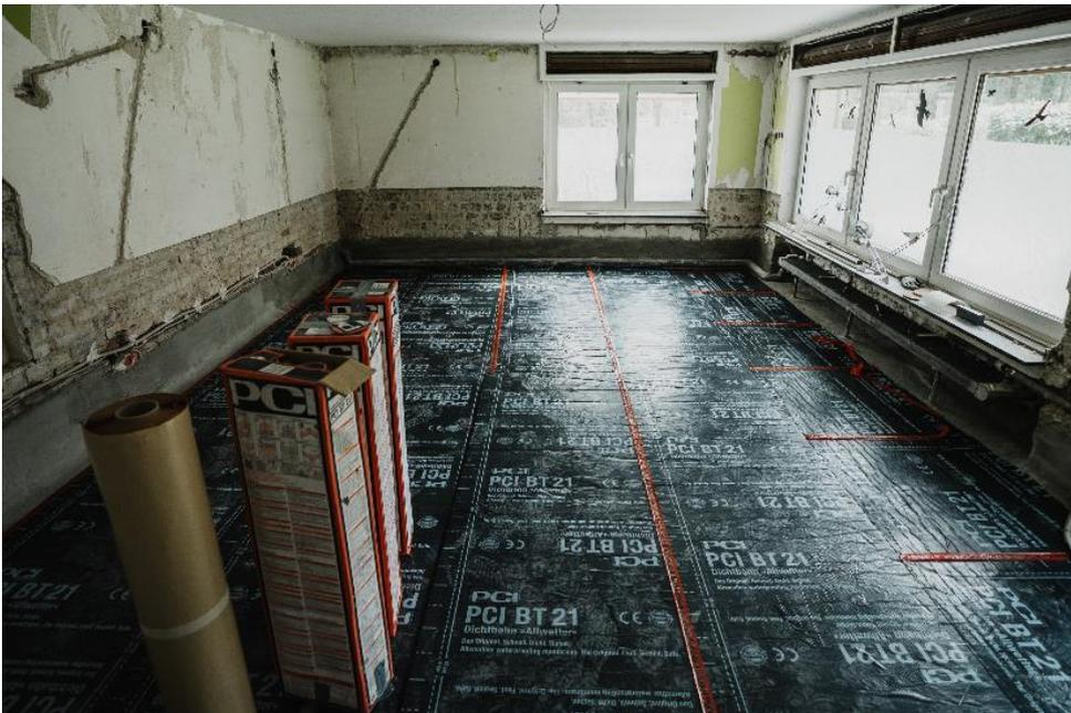
Moderne Abdichtungstechnik mit der KSK-Dichtbahn PCI BT 21, die sich einfach und schnell verarbeiten lässt.
