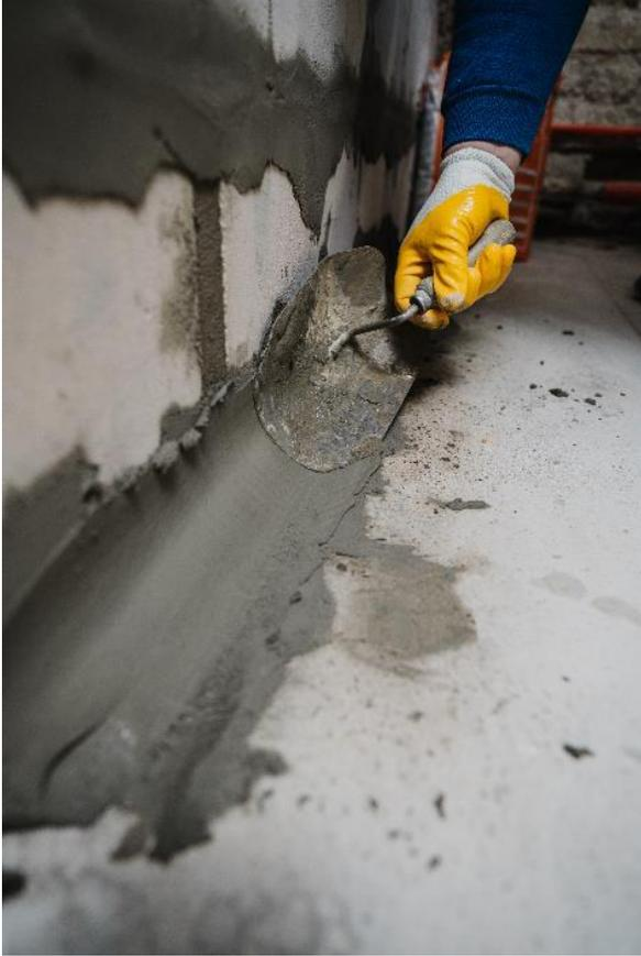
*Innenabdichtung mit PCI Polyfix Plus L zur Ausbildung einer dichten Hohlkehle
