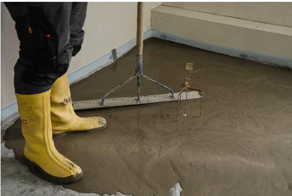
Der fließfähige Fertigmörtel PCI Novoment Flow ist bequem im Stehen verarbeitbar. ([Link](#) zum hochauflösenden Photo)
