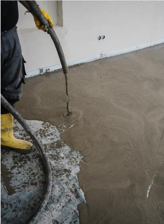
Ohne Wartezeit folgt der Einbau des Estrichs PCI Novoment Flow auf den mit PCI BT 21 abgedichteten Untergrund. ([Link](#) zum hochauflösenden Photo)
