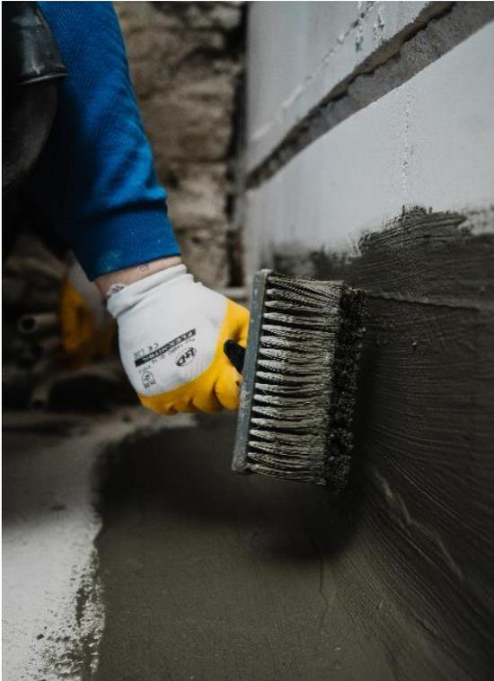
Die mineralische Dichtschlämme PCI Barraseal schützt vor eindringender Feuchtigkeit.
