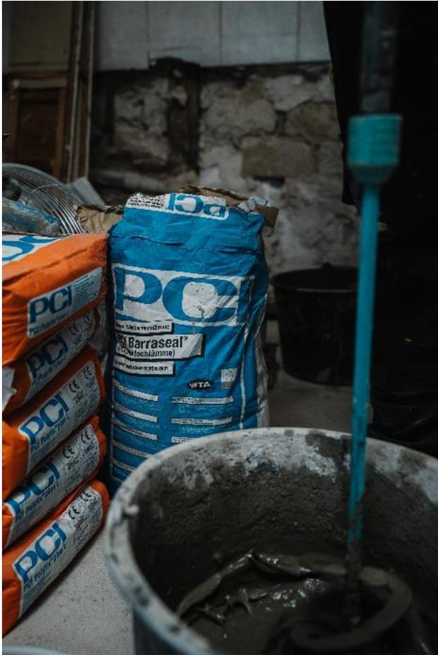
Den Boden-Wand-Übergang dichteten die Handwerker mit PCI Barraseal ab.
