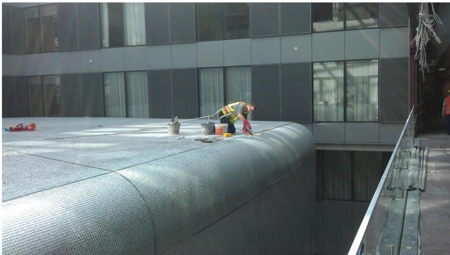
*Durch das neutrale Abbinden, die einfache Verarbeitung, die helle Farbe und vor allem seine exzellente Anhaftung und Flexibilität erwies sich der Dispersionskleber PCI Bicolit Classic als idealer Verlegewerkstoff für die anspruchsvollen Mosaikarbeiten.*
