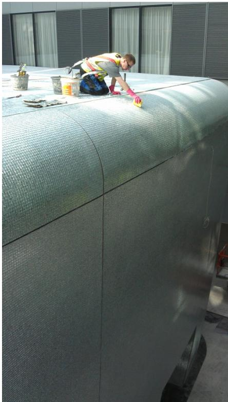
*Verfugung des Mosaiks mit einem zementären Fugenmörtel.*
