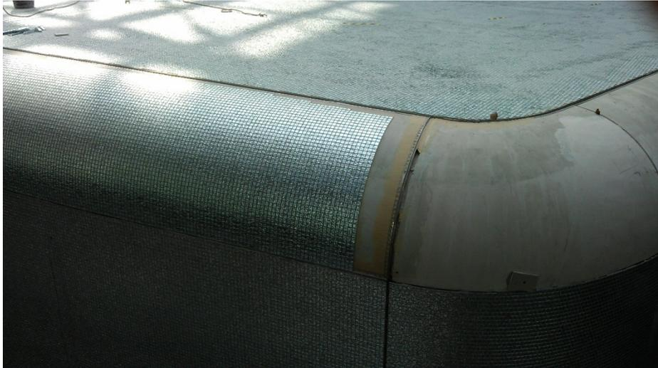
*PCI Bicolit Classic erleichterte das Verlegen des Mosaiks an den abgerundeten Außenkanten des Ballsaals deutlich.*
