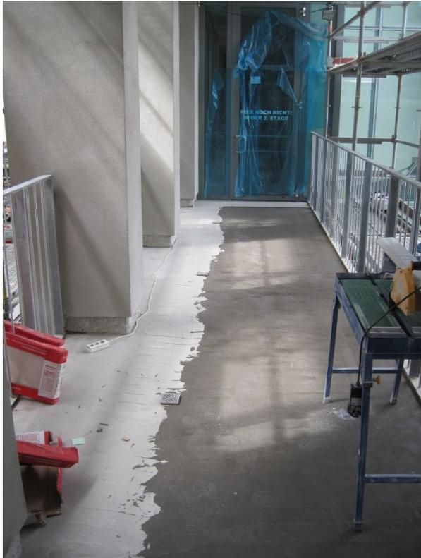
Nach Vorbereitung des Untergrunds wurde die Heizung mit PCI Carrament grau eingespachtelt und anschließend mit PCI Seccoral 2K Rapid abgedichtet.
