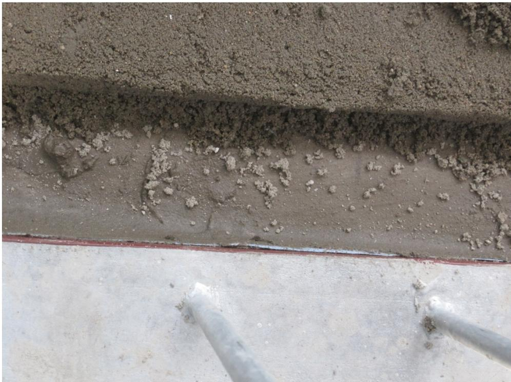
Der neue Estrich wurde bis circa 15 Zentimeter vor das Geländer eingebracht. Nach Grundierung und Abdichtung des Geländers erfolgte das Verfüllen der Aussparung mit einem alkalistabilen Epoxidharzmörtel.
