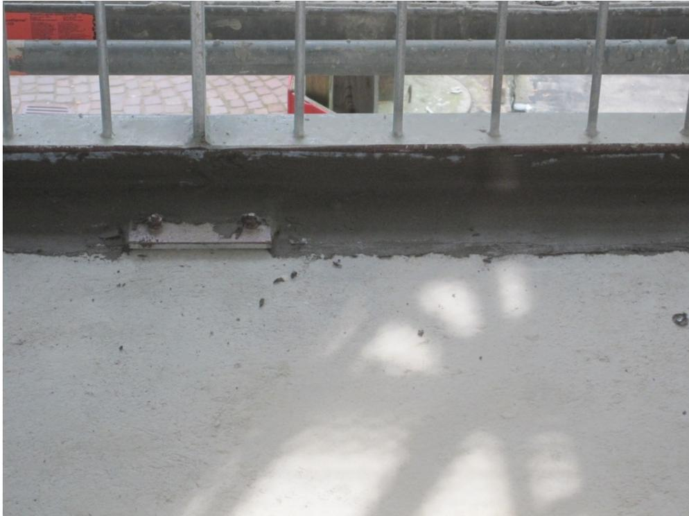
Als Korrosionsschutz trugen die Handwerker die Haft-Grundierung PCI Elastoprimer 220 auf, zusammen mit dem wasserdichten Spezial-Dichtband PCI Pecitape 250.
