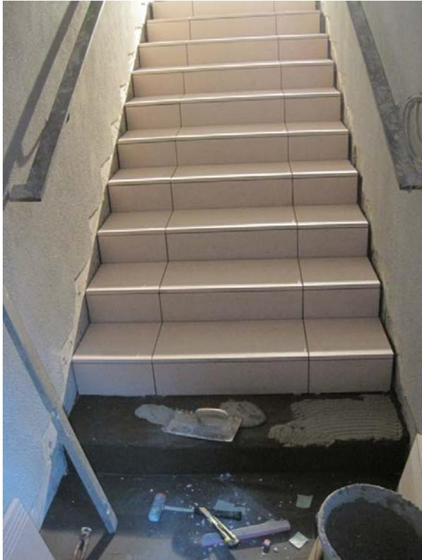
Über dem Heizsystem verlegten die Handwerker die Feinsteinzeugfliesen mit PCI Flexmörtel S2 und verschlossen die Fugen mit PCI Flexfug.
