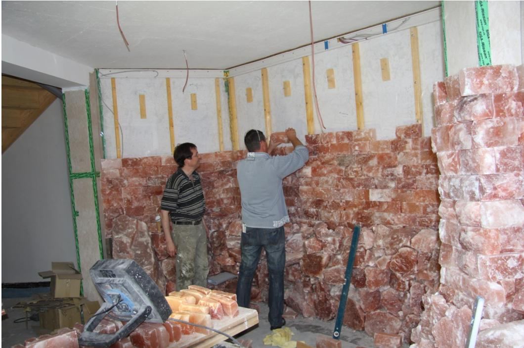
Bauherr und Bauunternehmer am Werk: Mit standfestem Ansetzkleber aus PCI Epoxigrund Rapid, PCI Stellmittel und PCI Bauharz lassen sich die Salz-Platten schnell und unproblematisch anbringen.
