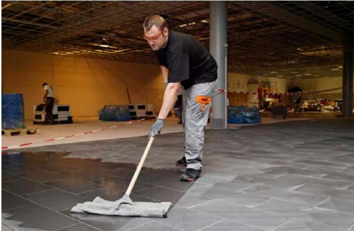
*Der Fugenmörtel PCI Rapidfug erhärtet schnell und ermöglicht dadurch eine rasche Vorgehensweise: Zwischen Einfugen und Waschen liegt eine nur sehr kurze Wartezeit.*
