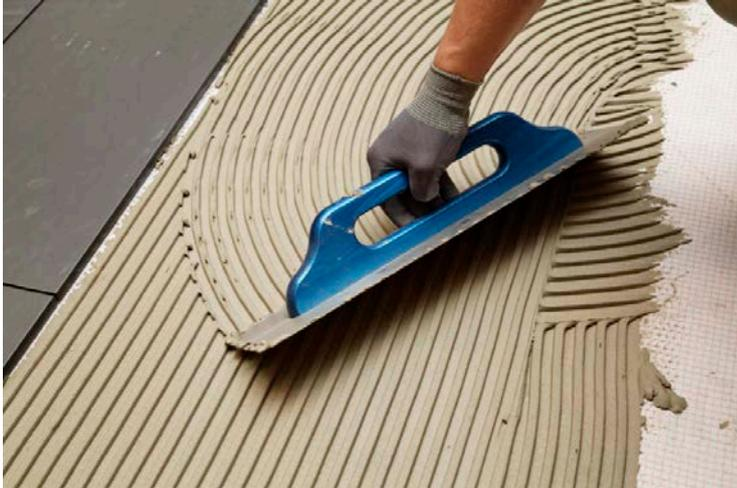
Der flexibilisierte Fliesenkleber PCI FT Extra kam auch bei der Verlegung der großformatigen Fliesen Topgres zum Einsatz.
