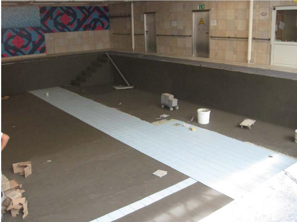
Die 20 x 20 cm großen Fliesen verlegten die Handwerker mit dem flexibilisierten Klebemörtel PCI FT Extra. Durch das Beimischen von PCI Lastoflex ergibt sich ein sehr verformungsfähiger Verlegemörtel, der Spannungen ausgleicht und enorm haftsicher ist.
