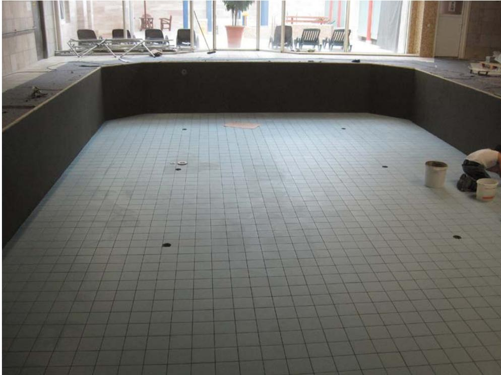
Für das Verfugen wählte die Suppro GmbH auf Anraten von PCI Anwendungstechniker Ingo Grollmisch den Spezial-Fugenmörtel PCI Durafug NT, der speziell für Schwimmbäder und auch Gewerbeflächen und Trinkwasserbehälter konzipiert ist.
