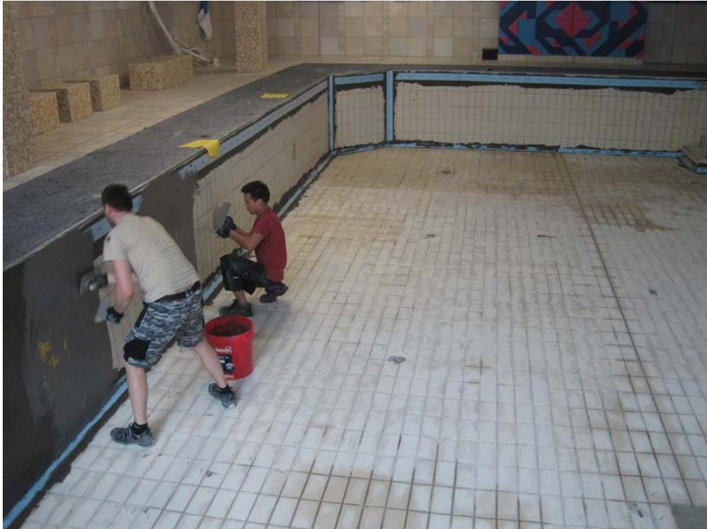
PCI Seccoral 2K Rapid lässt sich dank der geschmeidigen Konsistenz einfach verarbeiten – im Streich- oder Spachtelverfahren. Eck- und Anschlussfugen wurden mit PCI Pecitape 120 wasserdicht abgedichtet.
