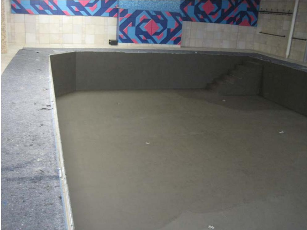
Mit Sicherheit dicht: PCI Seccoral 2K Rapid wirkt rissüberbrückend, entkoppelnd und spannungsabbauend – die optimale Beschichtung für das System „Fliese auf Fliese“.
