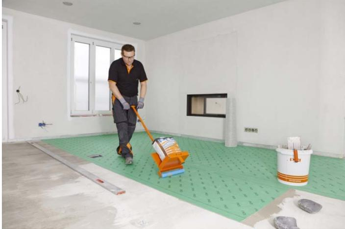
Bild 3: Die Handwerker walzen die Entkopplungsbahnen mit der praktischen PCI Andrückwalze fest. Das garantiert eine vollsattete Verklebung. Die Walze ist mit einer Aufnahmewanne ausgestattet, in der, je nach gewünschtem Anpressdruck, beispielsweise ein Sack Fliesenkleber zum Beschweren platziert werden kann.
