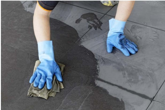
Bild 6 und 7: Das Verfugen der Fliesen erfolgte mit PCI Nanofug Premium. Der Fugenmörtel eignet sich für die Verarbeitung in Wohnräumen und in Nassbereichen. Der überschüssige Fugenmörtel lässt sich einfach von den Fliesen entfernen.
