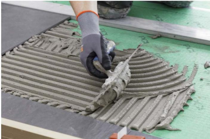
Bild 4 und 5: Die Verlegung im Fugenschnitt ergibt eine homogene Flächenwirkung. Den Fliesenbelag im Eingangsbereich verklebten die Fliesenleger mit dem hochflexiblen PCI Flexmörtel S2. Um Überzähne zu verhindern, wurden die Platten mit einem Nivelliersystem fixiert.
