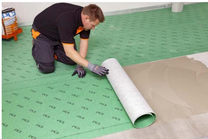
Bild 1 und 2: Die Entkopplungsbahnen PCI Pecilastic E wurden mit PCI Flexmörtel S2 auf den grundierten Bodenflächen verklebt.
