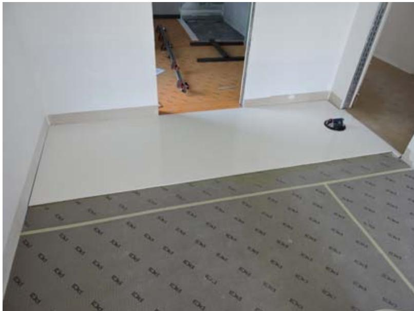
Foto 7 – Al fine di ridurre i tensionamenti, gli addetti alla posa hanno applicato il manto desolidarizzante PCI Pecilastic E con l'adesivo deformabile PCI Flexmörtel S1 Flott. Nel bagno è stato utilizzato il manto impermeabile e desolidarizzante PCI Pecilastic U.
