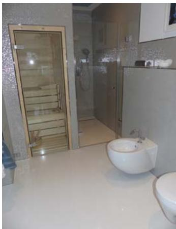
Foto 3 e 4 – Sulle pareti del bagno sono state posati circa 40 m<sup>2</sup> di piastrelle di grande formato 33 x 100 cm.
