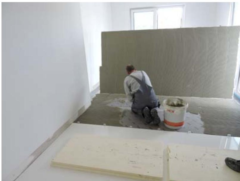
Foto 5 e 6 – Per ottenere una posa possibilmente senza vuoti delle lastre in grès porcellanato di grande formato i piastrellisti hanno applicato l'adesivo PCI Flexmörtel S1 Flott sul sottofondo preparato e sul retro delle piastrelle.
