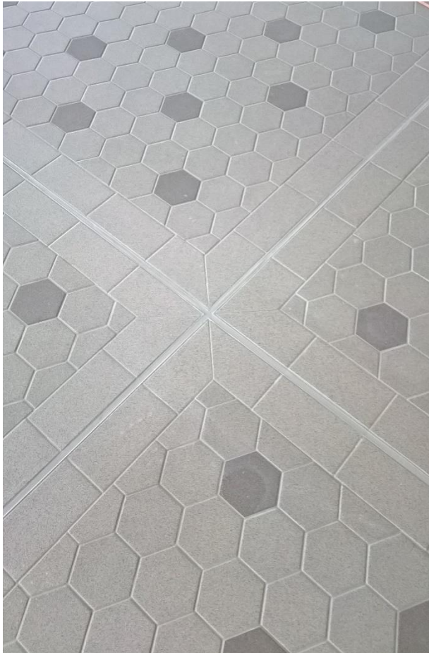
Bild 8: Gefällskorrekturen führten die Verarbeiter im Untergrund mit PCI Pericret aus. Die Dehnfugen wurden mit PCI Elritan 140 bewerkstelligt.
