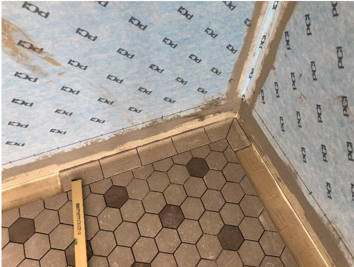
Bild 6: Den Boden-Wandanschluss führten die Verarbeiter mit Hohlkehlsockel aus.
