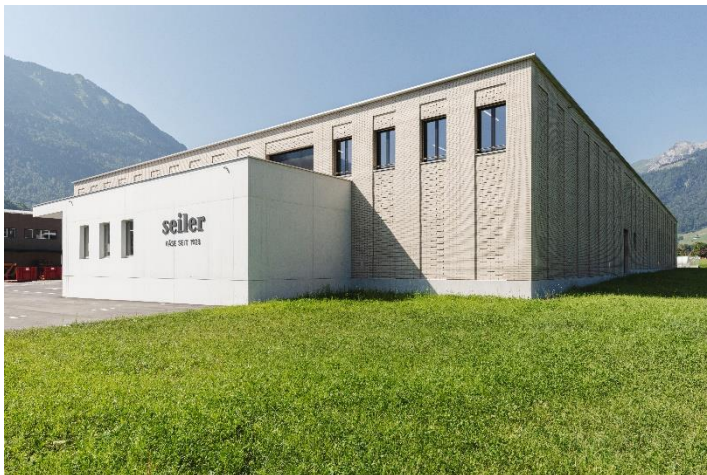
Bild 1: Die Käserei Seiler, ein Traditionsunternehmen mit 90-jähriger Geschichte, errichtete eine neue, hochmoderne Produktionsstätte in Giswil.
