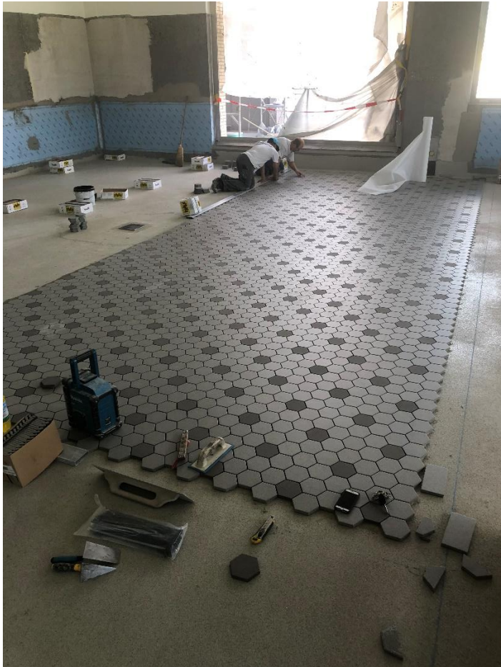
Bild 7: Die Verlegung der Bodenplatten erfolgte mit Einstreuer (Fläche mit dem Einlegen einer anderen Farbe optisch aufgelockert)
