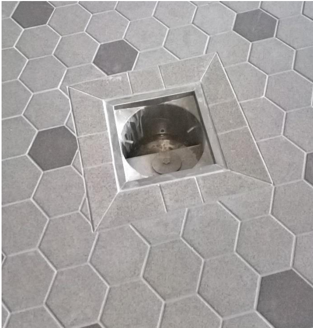
Bild 9: Für Bodenabläufe wie auch bei Boden-Wandanschlüssen kamen die Dichtbänder und Dichtecken PCI Pecitape in Verbindung mit PCI Apoflex F für die sichere Abdichtung zum Einsatz.
