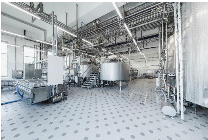
Bild 2: Planer und Bauherren entschieden sich für das PCI System Industrie, um die hohen Anforderungen bei der Plattenverlegung in milchverarbeitenden Betrieben zu erfüllen.
