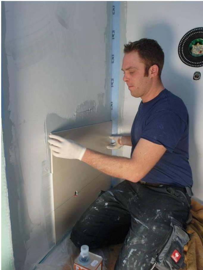
PCI Ocean Flex PUR wurde zunächst portionsweise auf dem Untergrund verteilt, damit die Reaktionswärme abfließen konnte. Anschließend spachtelte Thorsten Verhoeven eine dünne Schutzschicht auf den kompletten Untergrund und kämmte dann abschnittsweise jeweils so viel Material auf, wie er innerhalb einer Stunde belegen konnte. Die keramischen Fliesen wurden angesetzt und anschließend entsprechend ausgerichtet.
