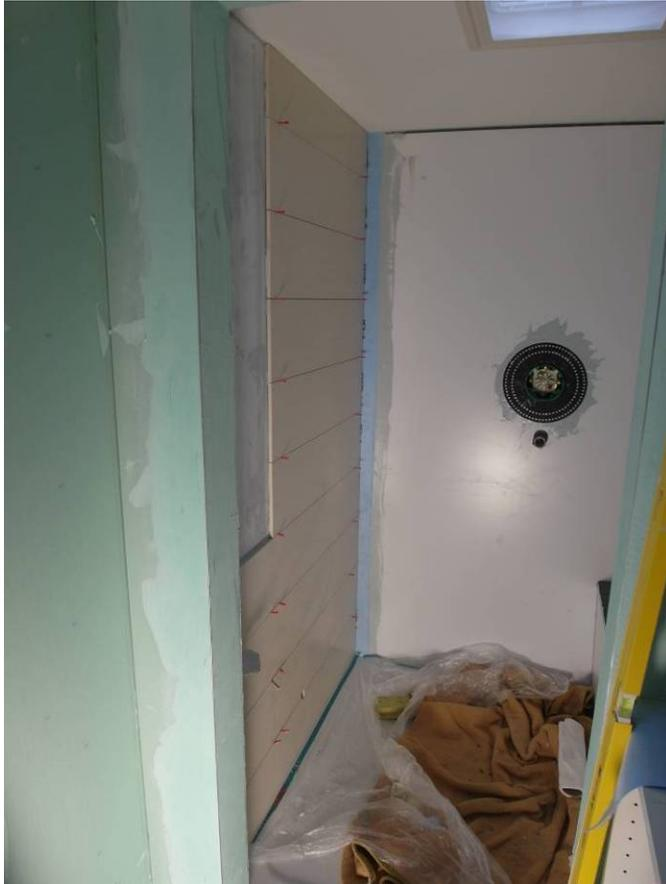
Den dauerhaften Halt der hochwertigen Keramikfliesen gewährleistet der Reaktionsharz Fliesenkleber PCI Ocean Flex PUR. Er verhindert zudem, dass der Belag durch die zu erwartenden Erschütterungen geschädigt wird.
