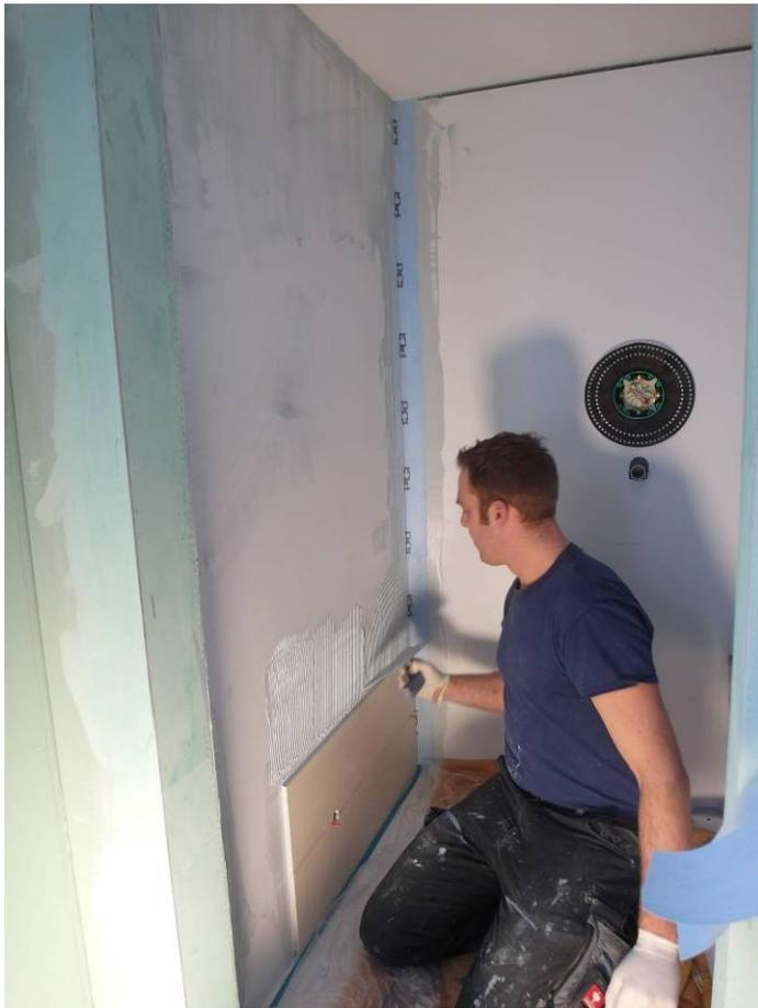
Bevor die Wabenverbundplatten mit Wandfliesen belegt wurden, dichtete Thorsten Verhoeven die Wand-/Wandanschlüsse mit dem wasserdichten Spezial-Dichtband PCI Pecitape 120 ab. Eingebettet wurde dieses in den Polyurethan-Fliesenkleber PCI Ocean Flex PUR, der im nächsten Arbeitsschritt auch zur Befestigung der Fliesen zum Einsatz kam.
