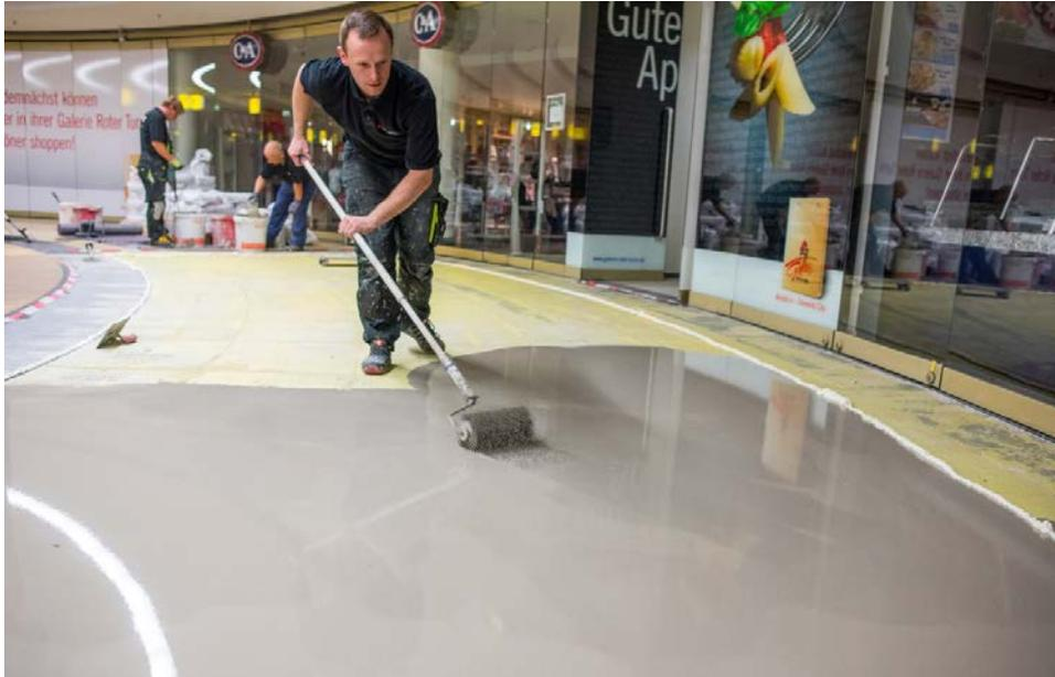
Zum Ausgleichen des Untergrunds wurden Höhepunkte gesetzt. Anschließend gossen die Handwerker die PCI Nivelliermasse auf den vorbereiteten Bodenbereich und verteilten sie gleichmäßig über den Untergrund.
