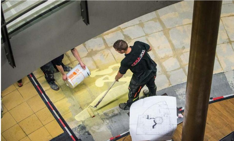
Für die Grundierung verwendeten die Verarbeiter PCI Gisogrund 303. Die lösemittelfreie und sehr emissionsarme Spezial-Grundierung lässt sich im Roll- und Streichverfahren einfach verarbeiten und ist dank der hellgelben Kontrollfarbe gut erkennbar.
