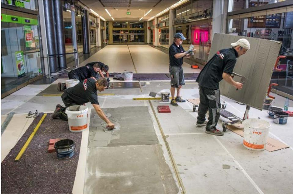
Auch für die Fliesenverklebung verwendete das Team von CERA-XXL den Flexmörtel S2 Rapid, der zusätzlich Untergrundspannungen verlässlich ausgleicht und dank der kurzen Abbindezeit das Begehen der neuen Beläge schon nach fünf Stunden ermöglicht.
