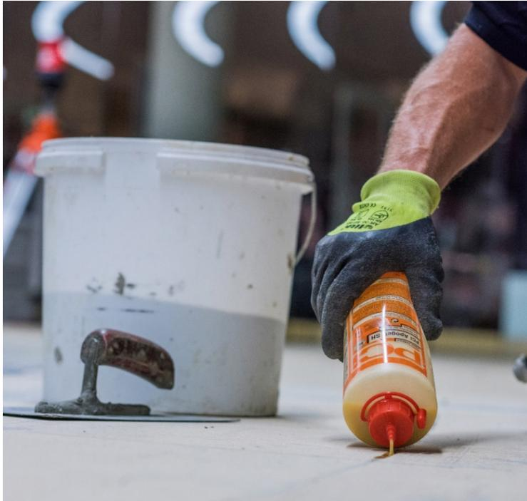
Zur Untergrundvorbehandlung wurden Hohllagigkeiten ausgebessert und offene Fugen mit dem geruchsneutralen Silikat-Gießharz PCI Apogel SH verschlossen.
