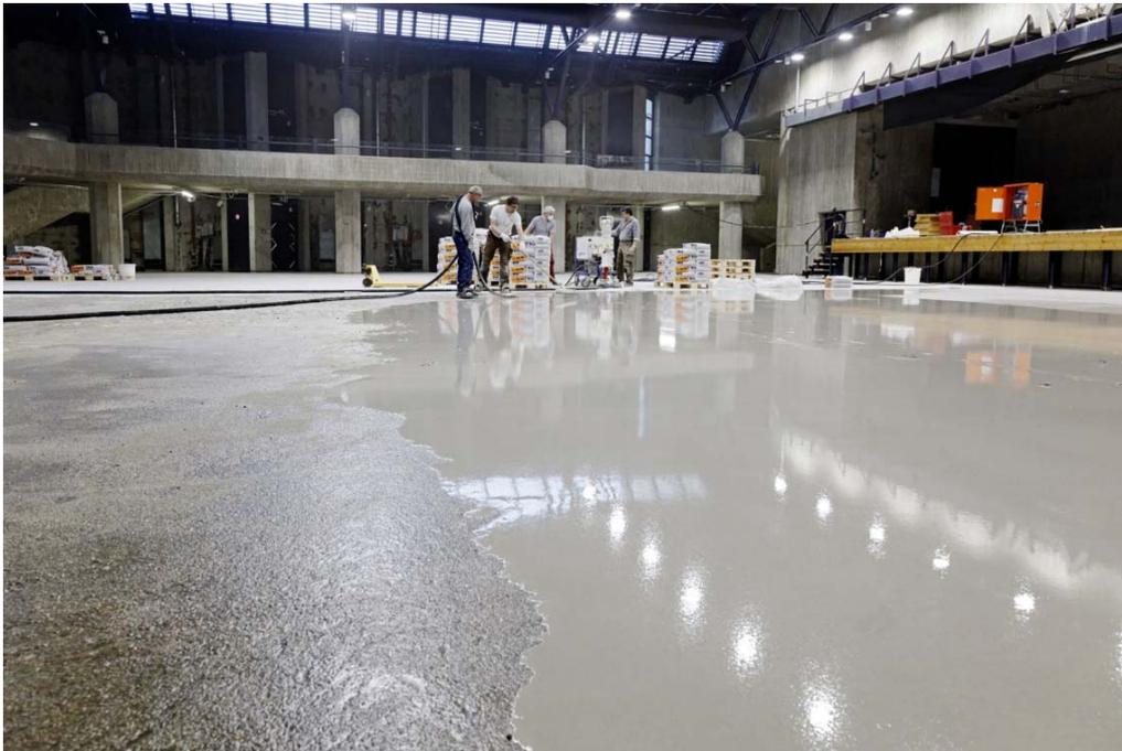
Bild 1: Weit über 1.000 Quadratmeter Bodenfläche standen in der Aula der Reischleschen Wirtschaftsschule in Augsburg zur Sanierung an. Ein Wasserschaden hatte Belag und Untergrund zerstört.
