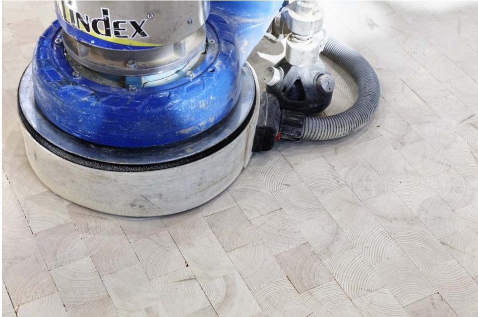
Bild 7: Nach der fachmännischen Verlegung des Holzpflasters wurde es abgeschliffen und seine Oberfläche eingölt.
