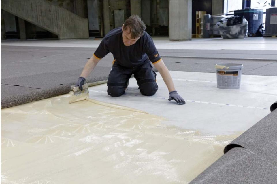
Bild 3: Auf der gehärteten und tragfähigen Spachtelmasse verkleben die Handwerker die Dämmunterlage PCI DU 903 FH mit dem lösemittelfreien SMP-Parkettkleber PCI PAR 365.
