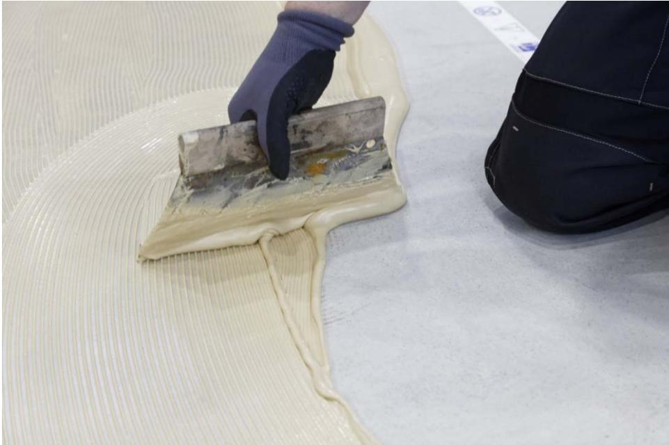
Bild 4: Die vollflächige Auslegung der Aula mit der Dämmunterlage wirkt entkoppelnd und mindert den Tritts- und Gehschall.
