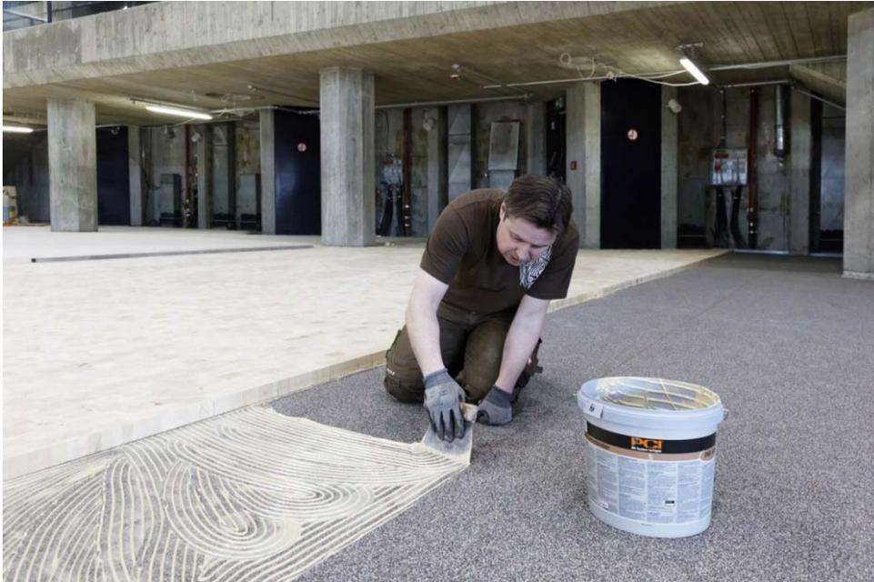
Bild 5: Auf der Dämmunterlage wurde das Holzpflaster mit dem SMP-Parkettkleber PCI PAR 365 verklebt.
