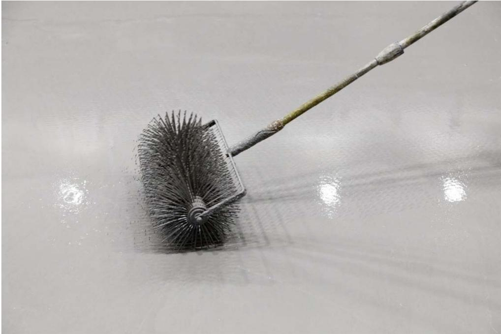
Bild 2: In nur zwei Tagen pumpten die Handwerker an die 20 Tonnen Universal-Spachtelmasse PCI USP 32 auf den Boden der Aula. Die Ausgleichsmasse ist leicht verlaufend, schleifbar, staub- und spannungsarm. Zum Entlüften dient eine Stachelwalze.
