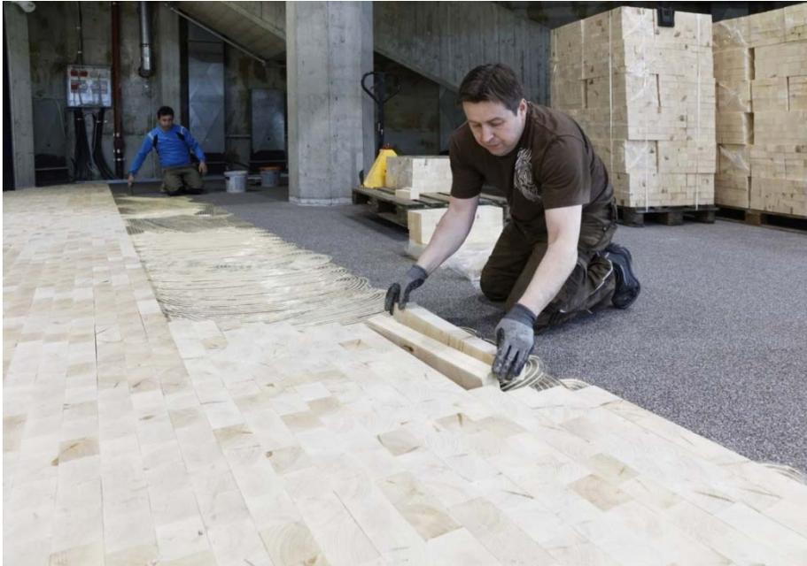
Bild 6: Da Holzpflaster größere Kräfte bei Schwund und Quellung entwickelt als normales Parkett, ist für die Verlegung ein spezieller Klebstoff notwendig.
