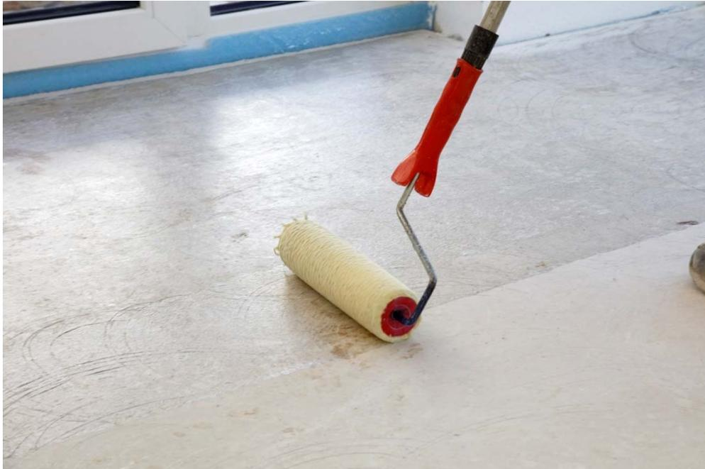
Bild 2: In der Energieeffizienzhaus Plus-Siedlung in Friedberg-Hügelshart bei Augsburg wurden im Innenbereich nur sehr emissionsarme Baustoffe zur Fliesenverlegung verwendet – von der PCI Augsburg GmbH. Für die Untergrundvorbereitung kam die Schutz- und Haftgrundierung PCI Gisogrund zur Anwendung.
