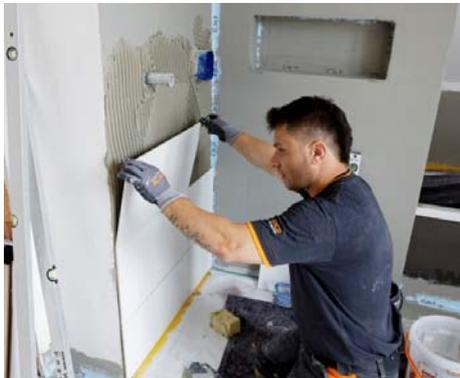
Bild 5 und 6: Für die Fliesenverlegung im Wohn- und Badbereich verwendeten die Fliesenleger PCI FT Extra. Aufgrund seiner hohen Benetzungsfähigkeit kann der Fliesenkleber auch auf schwach saugenden Untergründen eingesetzt werden und eignet sich darüber hinaus für Feinsteinzeugbeläge.
