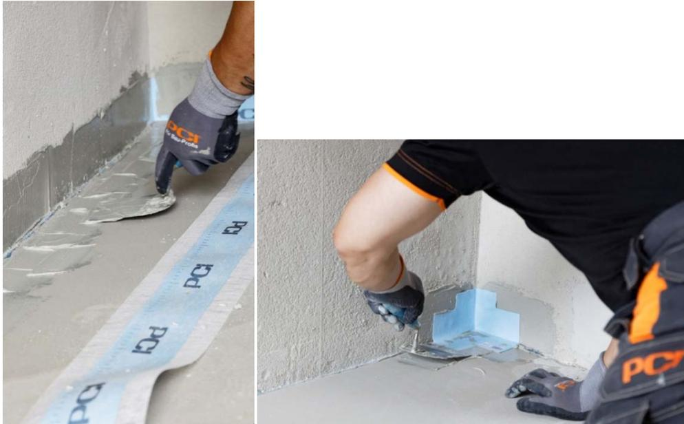
Bild 3 und 4: Zum Abdichten von Eck- und Anschlussfugen, von Innen- und Außenecken sowie Rohrdurchführungen und Bodenabläufen kamen die PCI Pecitape Dichtbänder, Dichtecken und Dichtmanschetten zum Einsatz.
