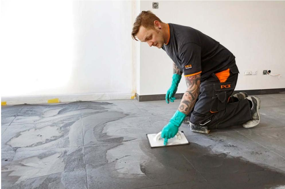
Bild 7: Die Fliesenbeläge wurden mit PCI Nanofug Premium verfugt. Der variable Flexfugenmörtel mit einem Verarbeitungsfenster von rund 40 Minuten lässt sich komfortabel einbringen und bindet schnell ab ohne aufzubrennen.
