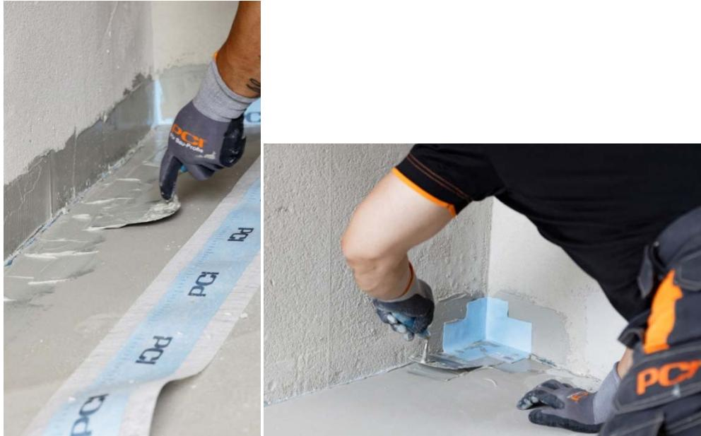
Foto 3 e 4 – Per sigillare i giunti d'angolo e di raccordo, gli angoli interni ed esterni, nonché i tubi passanti e gli scarichi da pavimento sono stati utilizzati nastri, angoli e manicotti della gamma PCI Pecitape.
