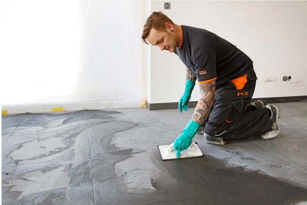
Foto 7 – La sigillatura delle fughe è stata realizzata con PCI Nanofug Premium. Questa malta flessibile a consistenza variabile con un tempo di lavorazione di circa 40 minuti è molto facile da applicare ed ha una presa rapida senza distacchi da ritiro.
