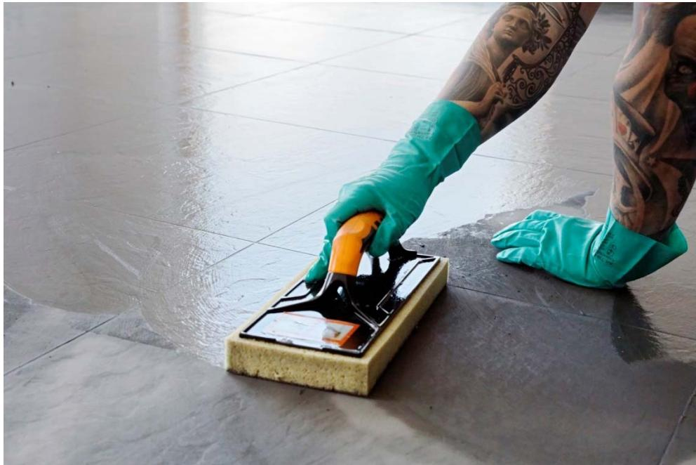
Foto 8 – I committenti apprezzano la superficie omogenea e la cromaticità molto brillante delle fughe. PCI Nanofug Premium si distingue per l'elevata resistenza ai detergenti acidi per uso domestico e la migliorata protezione contro determinate muffle e microrganismi. Grazie all'effetto «easy to clean» le fughe risultano molto facili da pulire.
