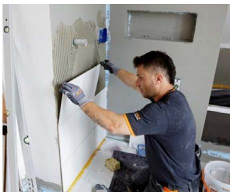
Foto 5 e 6 – Nella zona giorno e nei bagni le piastrelle sono state posate con l'adesivo PCI FT Extra. Grazie alla sua elevata capacità di bagnatura può essere utilizzato anche su sottofondi poco assorbenti ed è inoltre ideale per rivestimenti in grès porcellanato.
