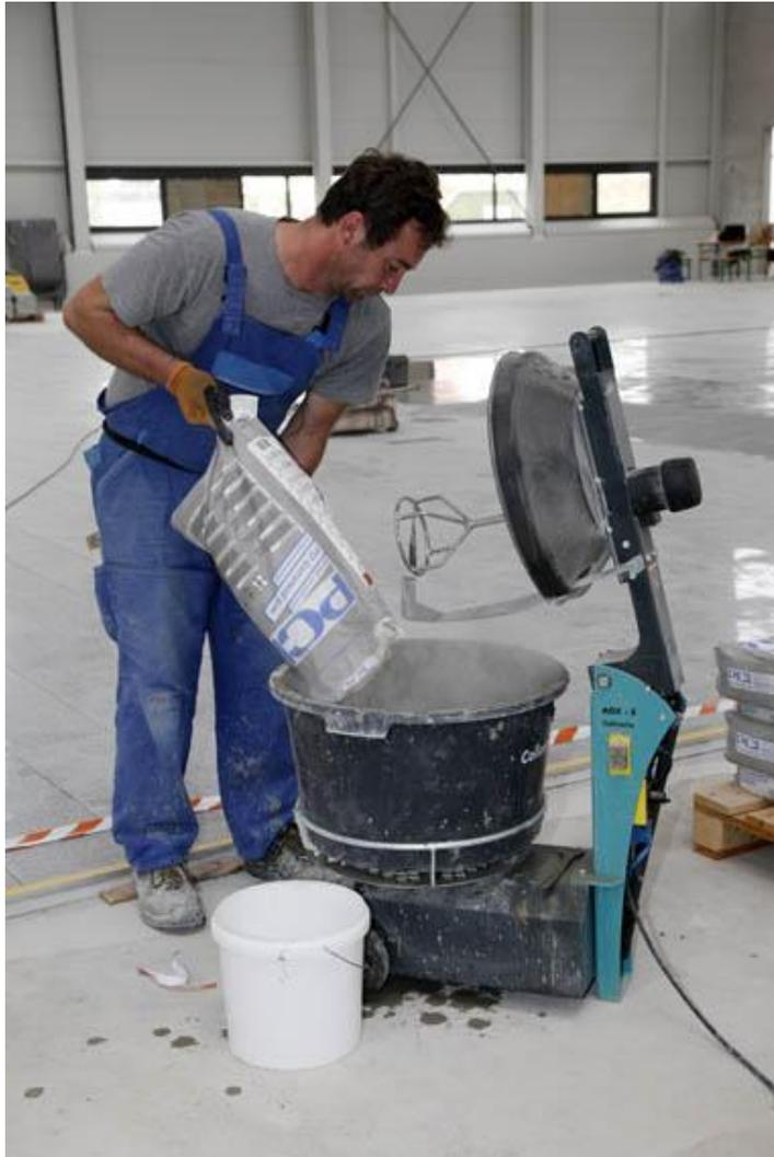
Beim Verlegen der Granit-Platten griffen die Verarbeiter auf einen Spezialisten der PCI Carra-Produktlinie zurück: Mit dem schnell abbindenden PCI Carrament grau wurde ein Verlegemörtel gewählt, der speziell auf die Besonderheiten und Anforderungen von Naturwerksteinbelägen zugeschnitten ist. Zum Anmachen des Mörtels wurde dieser zur entsprechenden Wassermenge hinzugegeben und mit geeignetem Mischwerkzeug zu einem plastisch-geschmeidigen Material angerührt.
