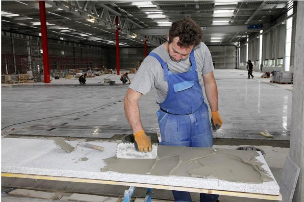
Um sicherzustellen, dass die Granitplatten weitestgehend vollsatt gebettet werden, um so die Bildung von Hohlräumen unterhalb des Belags zu vermeiden, wurde nach dem Battering-Floating-Verfahren gearbeitet. PCI Carrament grau wurde dabei nicht nur auf den Untergrund sondern auch auf die Rückseite der Granit-Platten in der gewünschten Stärke aufgetragen.
