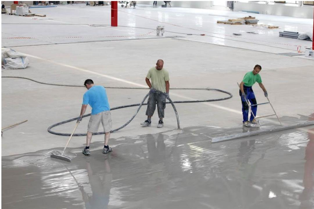
Nachdem die Stahlfaser-Betonplatte mit dem Kugelstrahlgerät entsprechend angeraut und die Fläche mit PCI Gisogrund grundiert wurde, brachten die Verarbeiter eine PCI-Nivelliermasse auf, um Unebenheiten auszugleichen.
