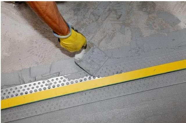
Im nächsten Arbeitsschritt galt es, die vorgesehenen Bewegungs- und Feldfugen einzurichten. Aufgrund der hohen mechanischen Belastung setzte man hierbei auf spezielle Schwerlastprofile. Fixiert wurden diese mit Hilfe des hochfesten Epoxidharzes PCI Durapox NT. Das zweikomponentige, hoch verschleißfeste Reaktionsharz-Bindemittel wurde entlang der vorgesehenen Flächen auf den vorbereiteten Untergrund aufgetragen, die Fugenprofile versetzt und wiederum mit PCI Durapox NT überarbeitet.
