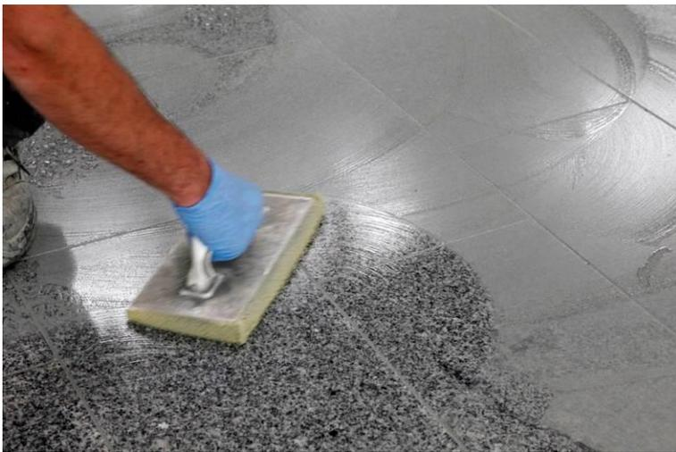
Da PCI Carrament bereits nach sechs Stunden begehbar ist, konnte mit der Verfugung innerhalb kürzester Zeit begonnen werden. Hierbei setzten die Verarbeiter auf den schnell abbindenden Flexfugenmörtel PCI Rapidfug.
