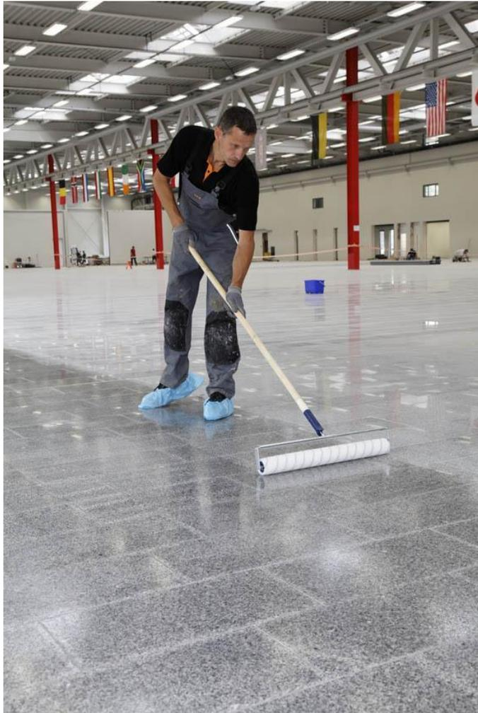
Nachdem der neue Bodenbelag gründlich mit dem für säureunempfindliche Natursteine geeigneten PCI Grundreiniger sauer gereinigt wurde, erfolgte die Imprägnierung der Granitoberfläche. Dazu kam die PCI Naturstein-Imprägnierung zum Einsatz. Diese wurde unverdünnt dünn aber deckend in zwei Arbeitsgängen aufgetragen. Das nicht eingezogene Material wurde nach einer Wartezeit von drei bis vier Stunden mit einem saugfähigen Tuch aufgenommen.
