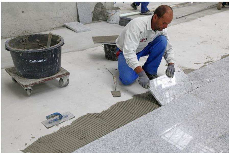
Anschließend wurden die Naturwerkstein-Platten eingedrückt und ausgerichtet. Das standfeste Klebebett sorgt bei gleichzeitig guter Benetzung dafür, dass die Platten nicht absacken.
