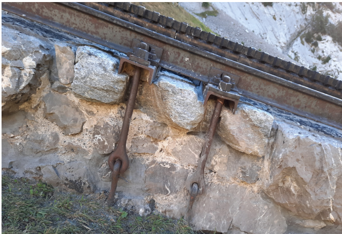
1) Besonders bemerkenswert ist der Unterbau: Statt herkömmlicher Schwellen ruht die Bahn auf einer massiven Trockensteinmauer, auf der Schienen und Zahnstange direkt befestigt sind.
