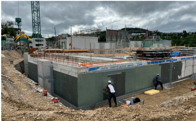
PCI Barraseal Turbo zeigt bei der Applikation einen Grüntich, der sich beim Trocknen grau färbt und so die Trocknung für die Folgebewehrung mit PCI Barraseal Turbo anzeigt.
