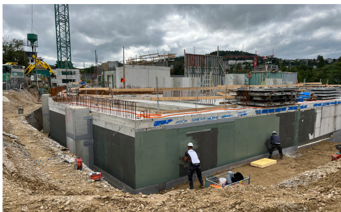
PCI Barraseal Turbo zeigt bei der Applikation einen Grüntich, der sich beim Trocknen grau färbt und so die Trocknung für die Folgebeseichnung mit PCI Barraseal Turbo anzeigt.
