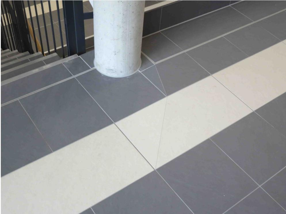
*Die Ausgleichsarbeiten in den Treppenhäusern wie auch die Angleichung der unterschiedlichen Höhen führten die Fliesenleger auf Empfehlung mit dem Reparaturmörtel PCI Nanocret R2 aus.*
