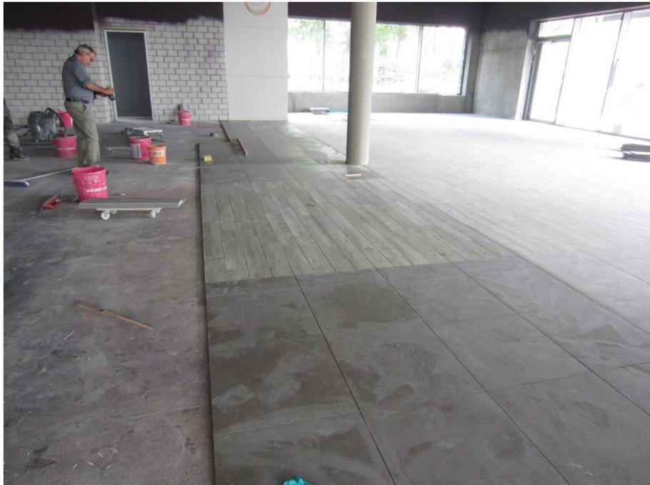
Schon nach drei Tagen konnten die Feinsteinzeugplatten auf dem noch feuchten Zementstrich verlegt werden. Mit PCI Flexmörtel S2 Rapid ist die frühe Belegung ohne Risiko möglich: Der Spezial-Fliesenkleber wirkt spannungsabbauend und entkoppelnd.
