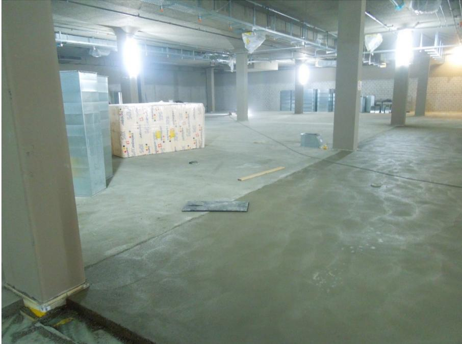
Das Zeitfenster für den gesamten Innenausbau war eng. Für den Einbau des Unterlagsbodens und die Plattenarbeiten standen nur rund sechs Wochen zur Verfügung. Für den schwimmenden Überzug in einer Dicke von 80 bis 100 mm wurden 80 Tonnen Mörtel verarbeitet – bestehend aus einer Baustellenmischung mit dem Bindemittel PCI Novoment Z3.
