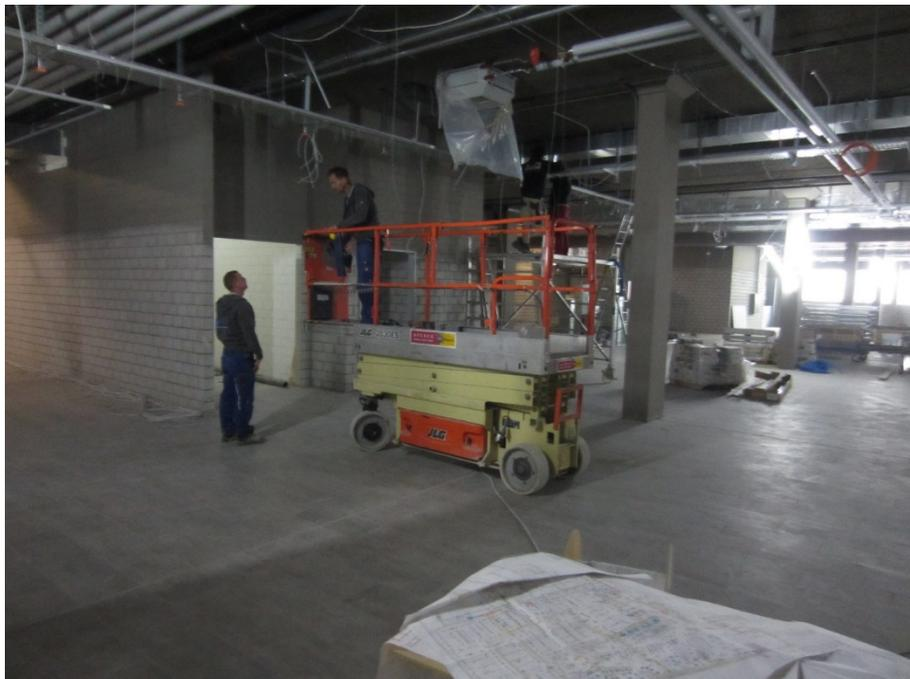
Aufgrund des engen Zeitfensters war eine rasche Belastung sowohl des Unterlagsbodens als auch des fertig verklebten Plattenbelags notwendig. Mit Hebebühnen wurde die Deckeninstallation angebracht. Ein unabhängiges Prüflabor bestätigte die Belastbarkeit durch Festigkeitsprüfungen.
