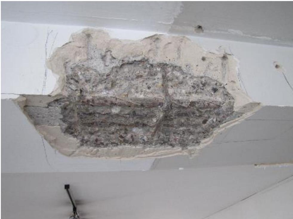
*Für die Nutzungsänderung eines ehemaligen Möbelhauses in Siegen musste der Bauzustand überprüft werden. Hierfür wurden Kernbohrungen an Decken durchgeführt und Stützsäulen wie auch Unterzüge freigelegt.*
