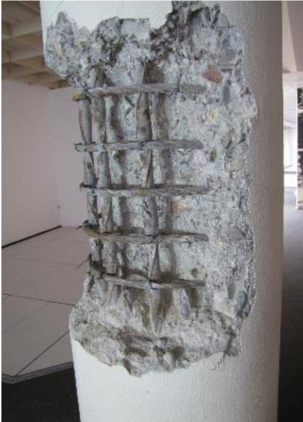
*Um die Tragfähigkeit der stark freigestemmt Stützen zu garantieren, musste die Reprofilierung sehr schnell erfolgen.*
