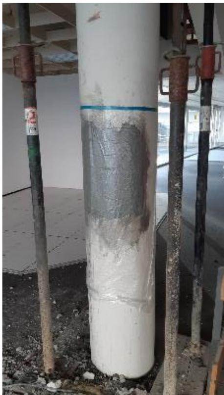
Nach Reprofilierung mit PCI Nanocret R4 Rapid erfolgte die Nachbehandlung mittels Folie.
