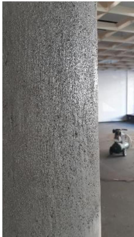
Die frisch eingebrachte Reprofilierung mit PCI Nanocret R4 Rapid erfüllt alle Anforderungen an Druck- und Haftzugfestigkeit und stellt die Tragfähigkeit der Betonteile sicher.
