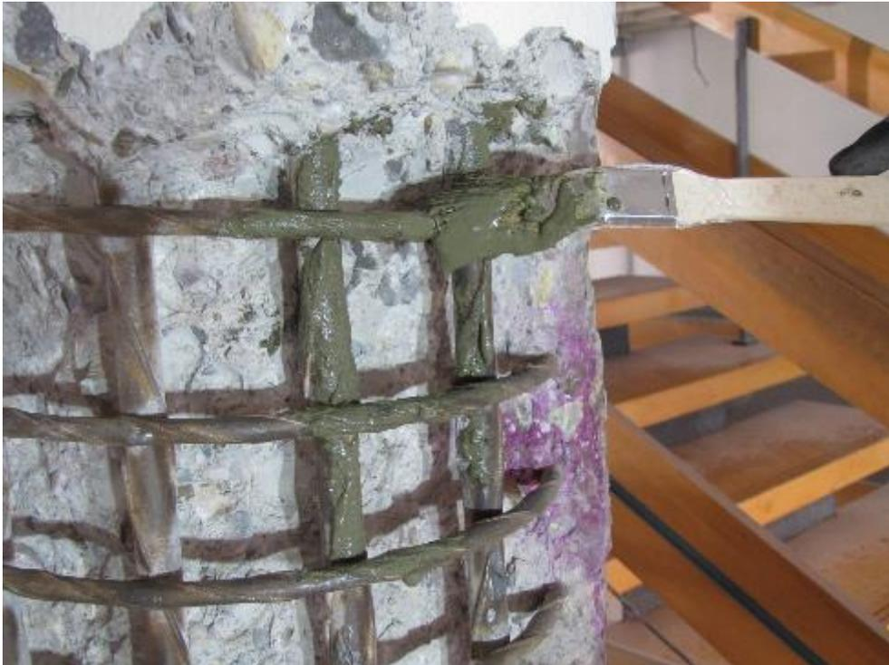
*Für den Korrosionsschutz kam PCI Legaran RP zur Anwendung. Durch Aufsprühen der Indikatorlösung Phenolphthalein wird eine eventuelle Karbonatisierung erkennbar.*
