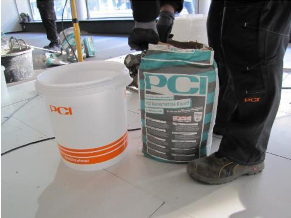
Für die schnelle und sichere Reprofilierung aller freigelegten Stellen empfahl PCI-Anwendungstechniker Stephan Leistner den schnellen Reparaturmörtel PCI Nanocret R4 Rapid.
