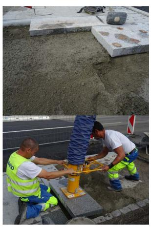
Bain de mortier et mise en place des dalles avec la machine à ventouse
