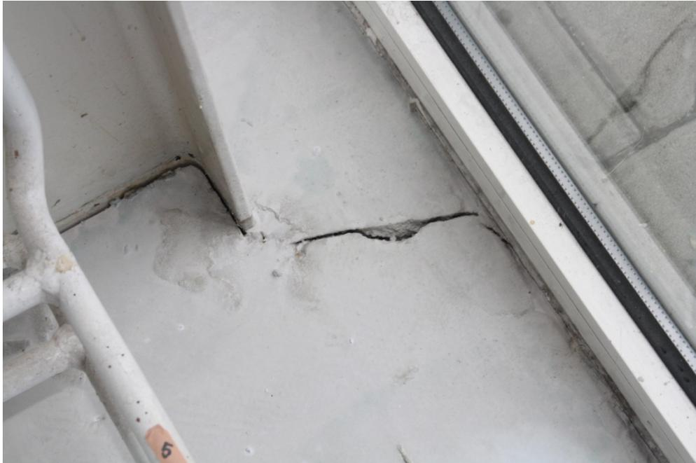
*Basis für eine sichere Fliesenverlegung ist die Untergrundbehandlung: Nach dem Rückbau des alten Fliesenbelags wurden bestehende Risse mit dem Gießharz PCI Apogel F kraftschlüssig verschlossen und PCI Estrichklammern zur Rissvernadelung verwendet.*
