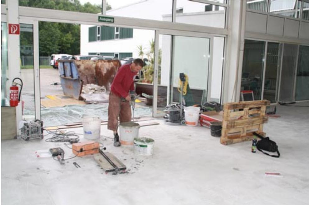
*Für die Fliesenverlegung im Autohaus die ideale Lösung: PCI Flexmörtel S2 gleicht Temperaturschwankungen und Untergrundspannungen zuverlässig aus. Der Fliesenkleber lässt sich mit Anmachwasser und dem geeigneten Rühr- und Mischwerkzeug einfach zu einem plastischen, knollenfreien Mörtel anrühren.*
