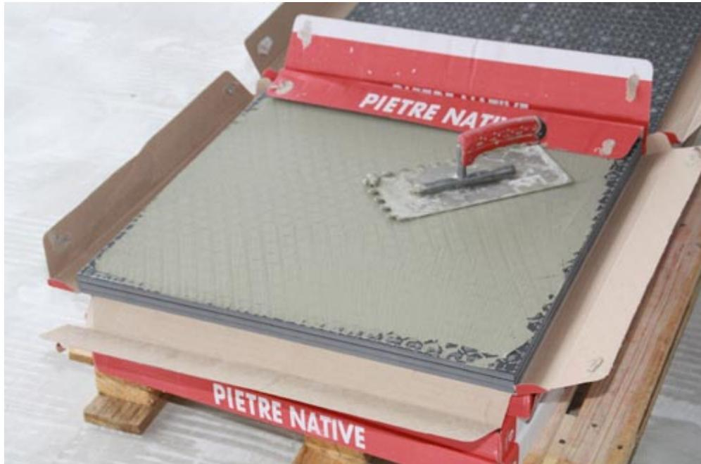
*PCI Flexmörtel S2 wurde auf Untergrund und Fliesenrückseite aufgebracht. Auf dem Untergrund sollte zunächst eine dünne Kontaktschicht mit der glatten Seite der Stahlkelle aufgezogen, darauf anschließend der Mörtel mit der Zahntraufel aufgekämmt werden.*
